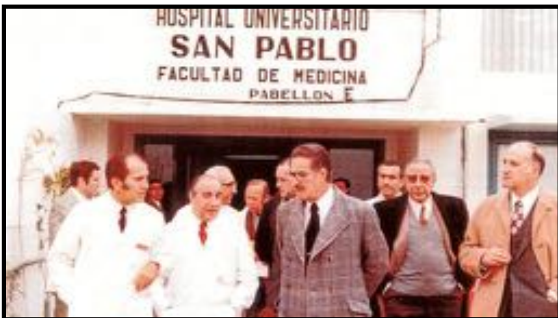
HOSPITAL CLÍNICO DE SAN PABLO 8-2-1973
