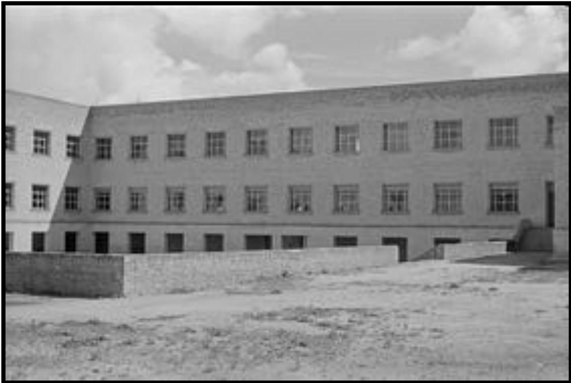
LAS OBRAS EN 1960 DE LA FACULTAD. IMAGEN DEL PATIO DE FISIOLÓGIA
